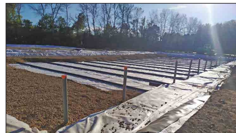
Nouveaux bassins pour l'assainissement collectif
