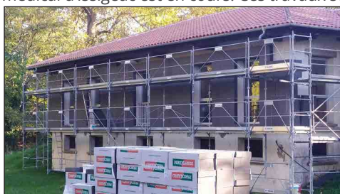
Centre Médical en cours d'isolation par l'extérieur
